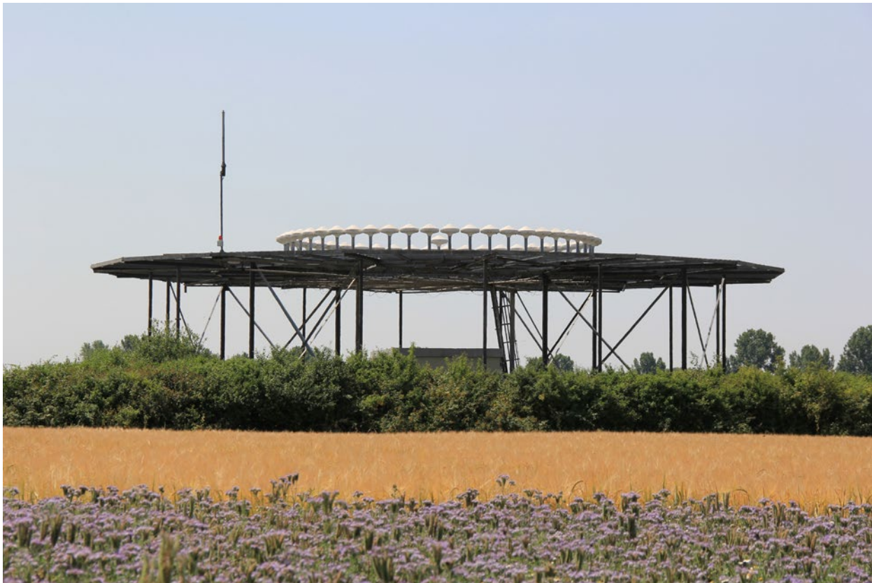
Abbildung 5 Das Doppler-UKW Drehfunkfeuer Ried bei Darmstadt ist eine Einrichtung der Flugsicherung, welches für den Betrieb am Flughafen Frankfurt wichtige Daten liefert. Quelle: BAF
