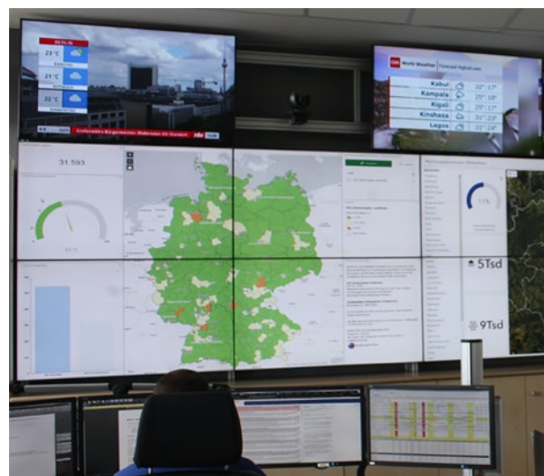
Abbildung 15 Geoinformationen sind aus der täglichen Arbeit des Bevölkerungsschutzes nicht mehr wegzudenken. Hier ein Blick in das gemeinsame Melde- und Lagezentrum von Bund und Ländern (Quelle: BBK).
